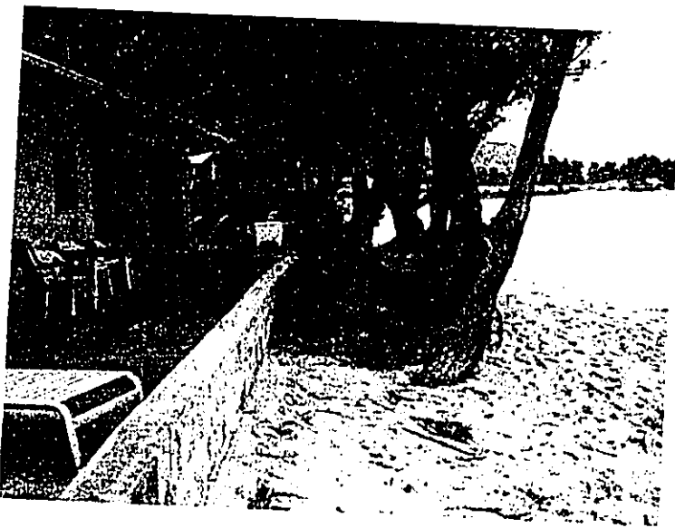
CMU wall fronts Parcel 13 .
