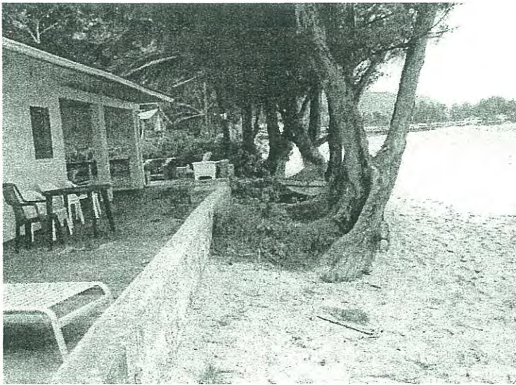
CMU wall fronts Parcel 13 .
