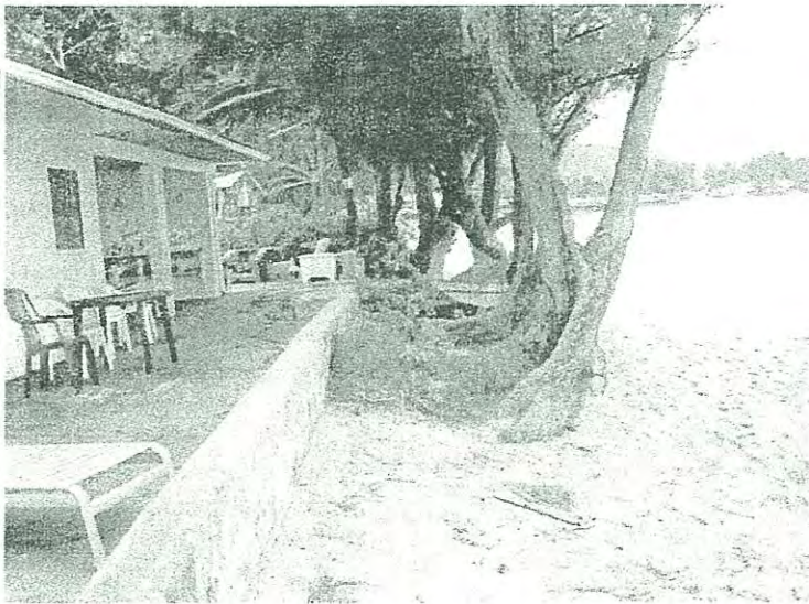
CMU wall fronts Parcel 13 .
