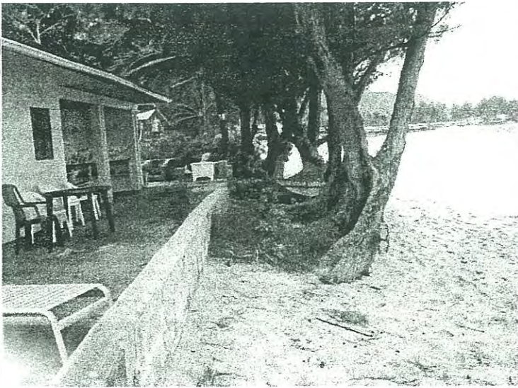
CMU wall fronts Parcel 13 .
