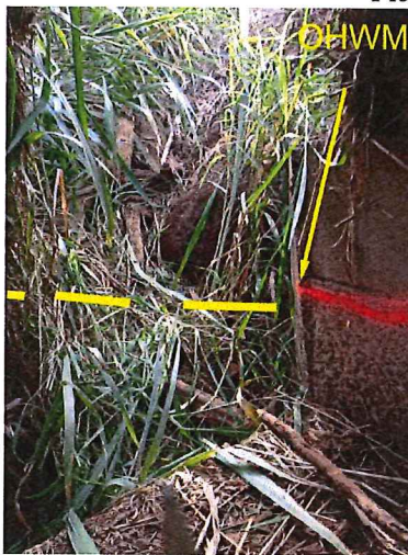
Flag Culvert Left
