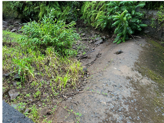
New Hāmākua Ditch Intake
